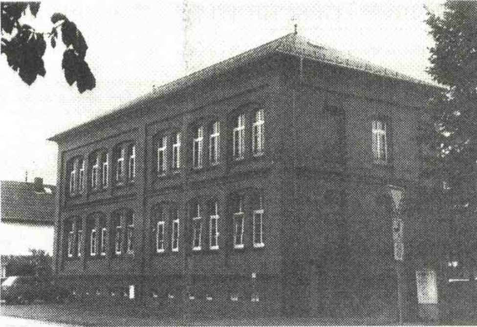
Das 100 Jahre alte Schulhaus in Ettingshausen im Herbst 1995.
